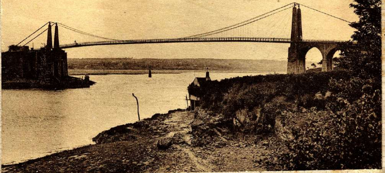
Lézardrieux — Pont suspendu métallique construit vers 1838, en remplacement d'un bac (1).
