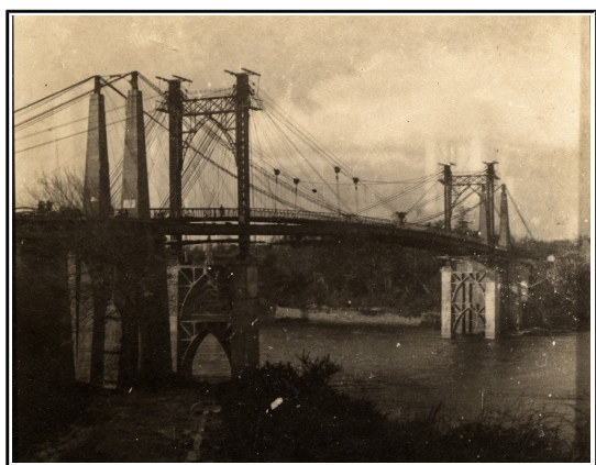
Les deux ponts superposés pendant les travaux (coll. Cl Roy)
